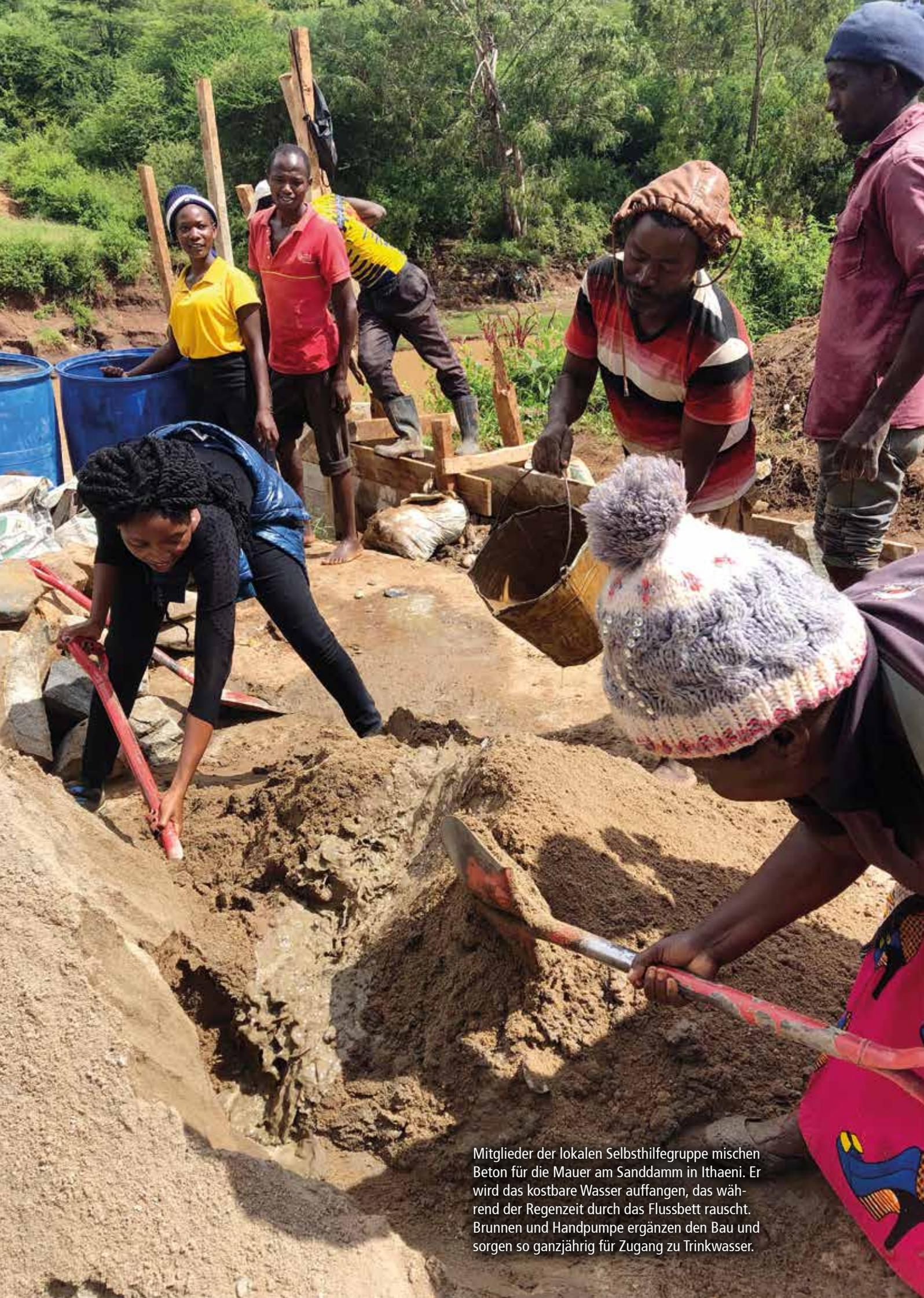
Mitglieder der lokalen Selbsthilfegruppe mischen Beton für die Mauer am Sanddamm in Ithaeni. Er wird das kostbare Wasser auffangen, das während der Regenzeit durch das Flussbett rauscht. Brunnen und Handpumpe ergänzen den Bau und sorgen so ganzjährig für Zugang zu Trinkwasser.
